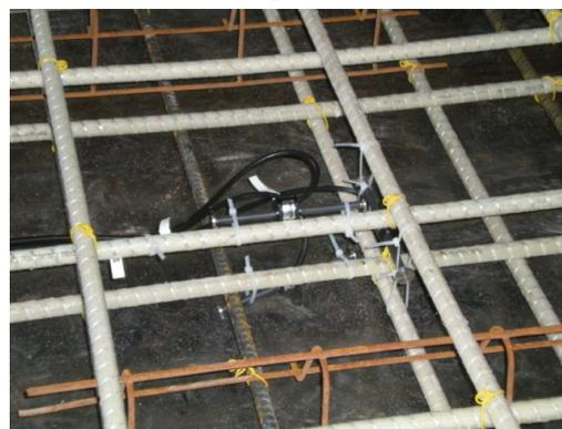
b.) HS-SCC GFRP VWSG Arrangement
